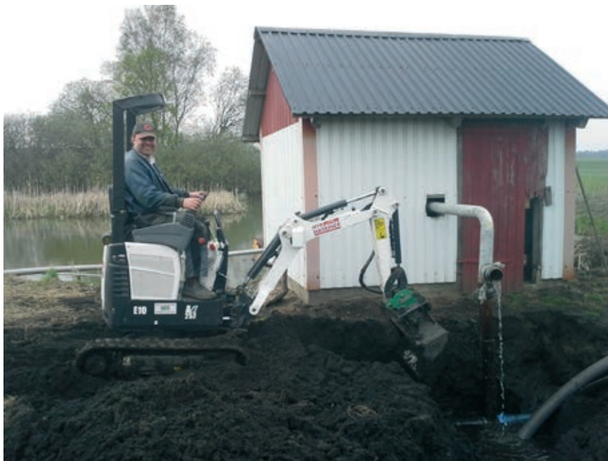
Erik leker grävmaskinist
